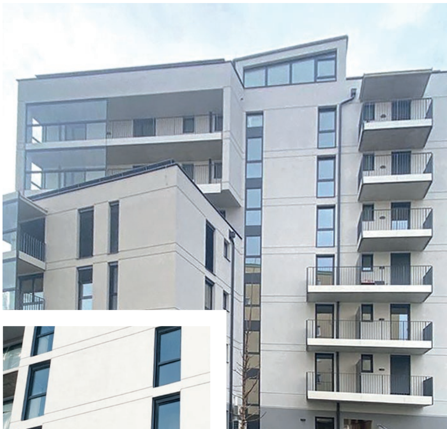
Austrotherm Nutprofil zum Einlegen in das WDVS
