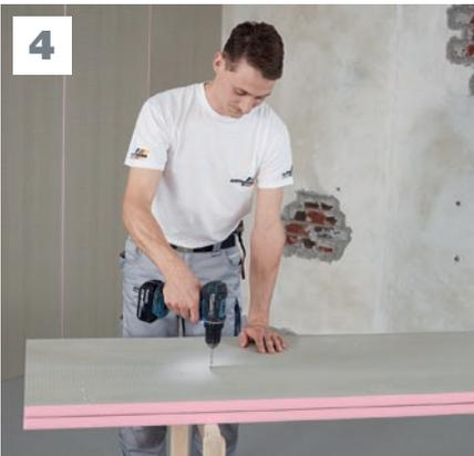
**4 Befestigungspunkte vorbohren**
